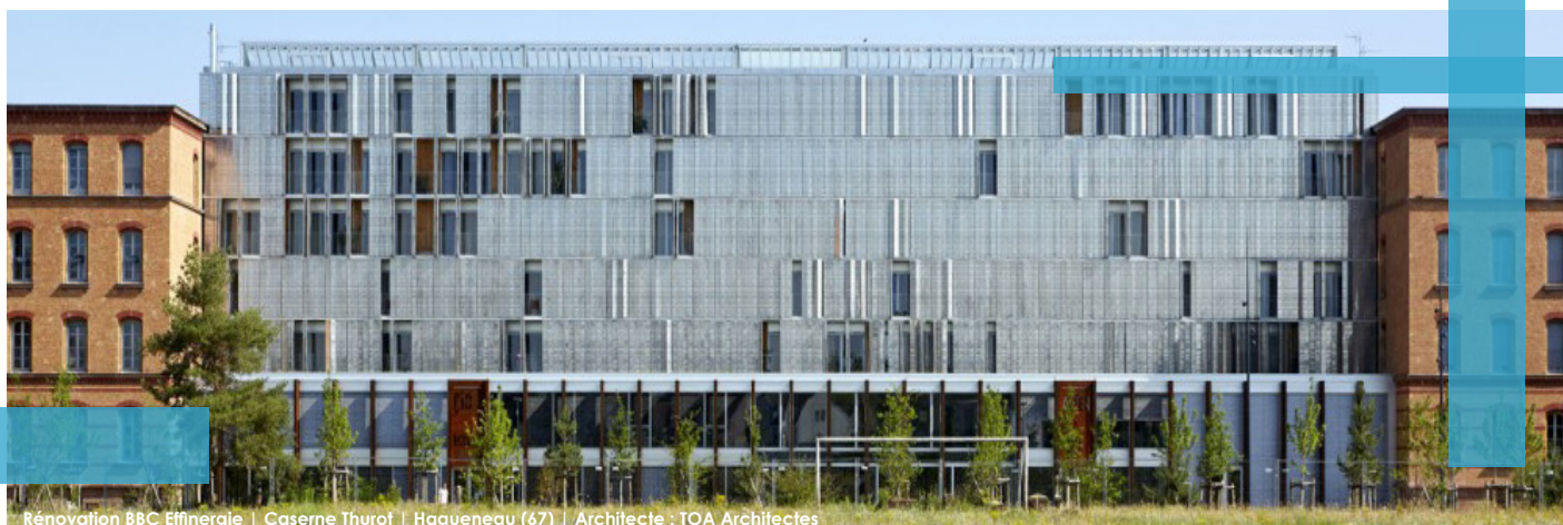
Rénovation BBC Effinergie | Caserne Thurot | Haguenau (67) | Architecte : TOA Architectes
